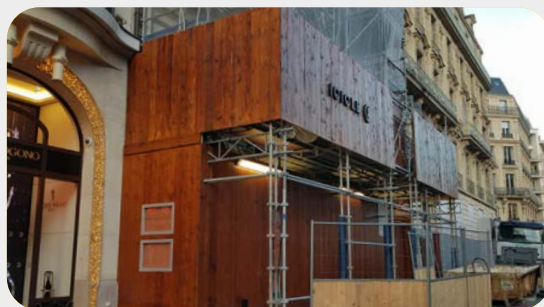
Habillage d'un échafaudage.
