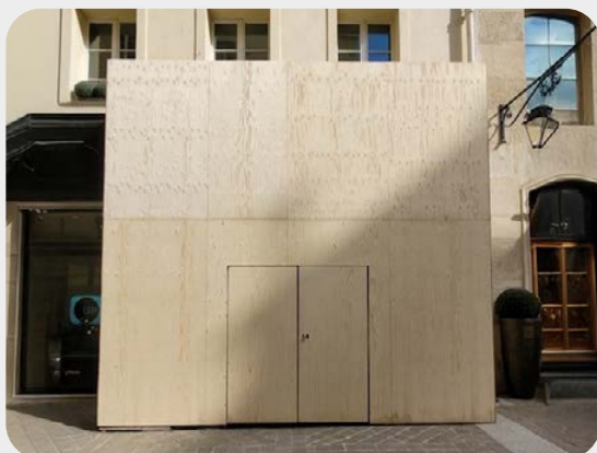
Palissade en contreplaqué extérieur.
