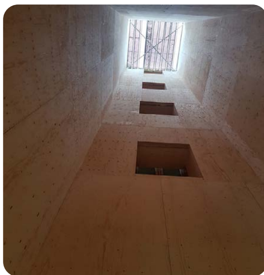
Habillage d'un échafaudage Pour évacuation des gravats
