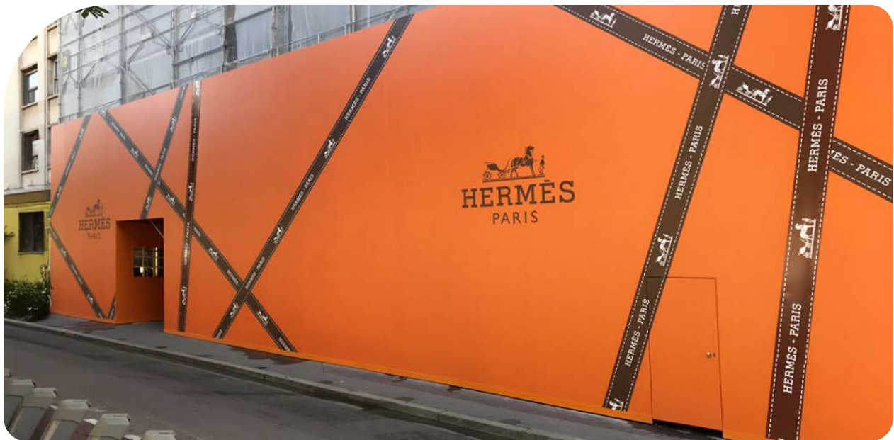
Bâche sur une palissade en contreplaqué
