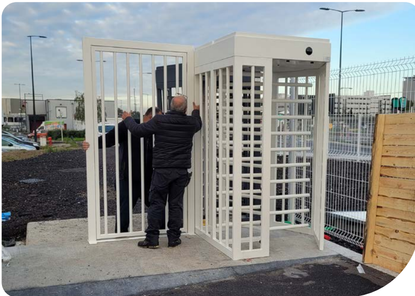
Installation tourniquet de sécurité
