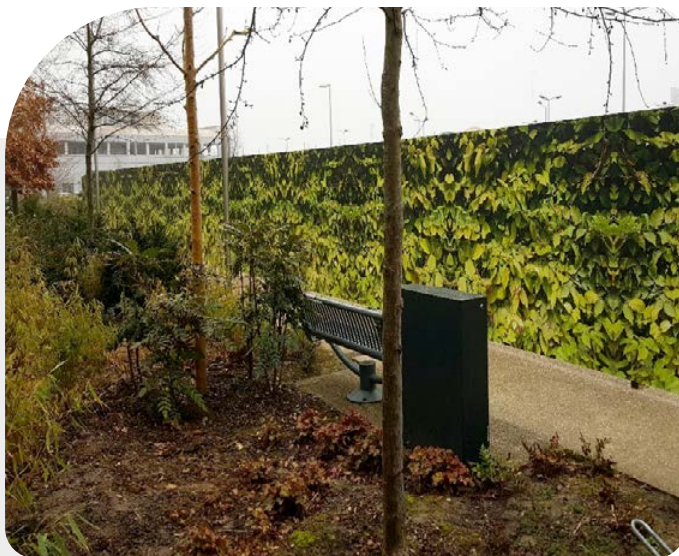
Adhésivage sur une palissade en alu dibond
