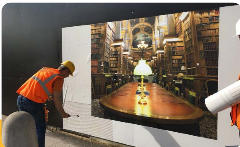
Adhésivage sur une palissade en contreplaqué
