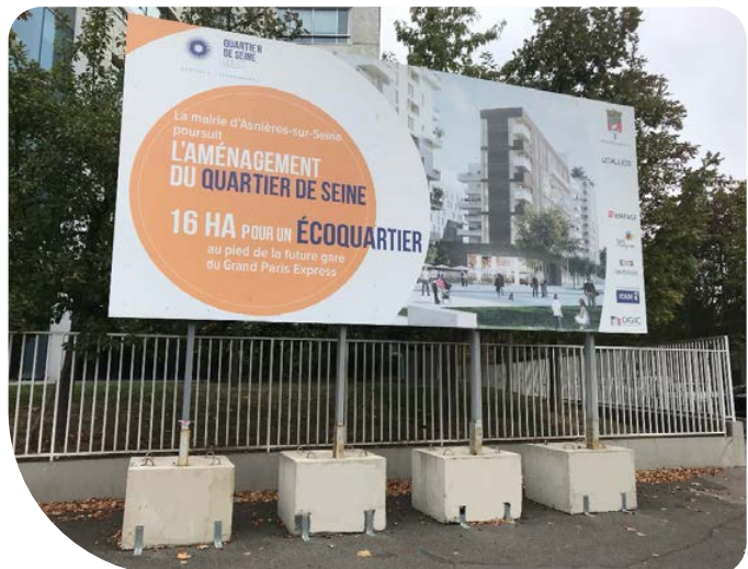
Panneau de chantier lesté
