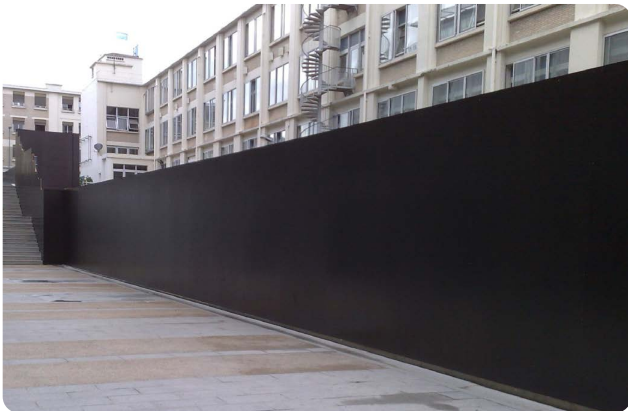
Palissade en Contreplaqué extérieur
