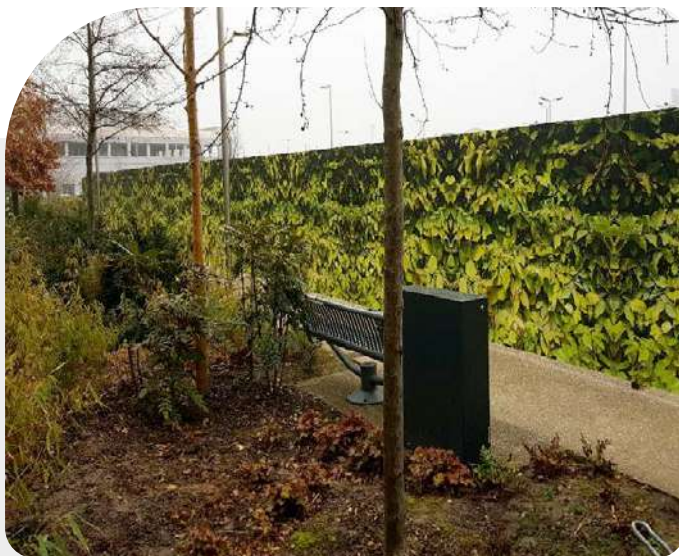
Adhésivage sur une palissade en alu dibond
