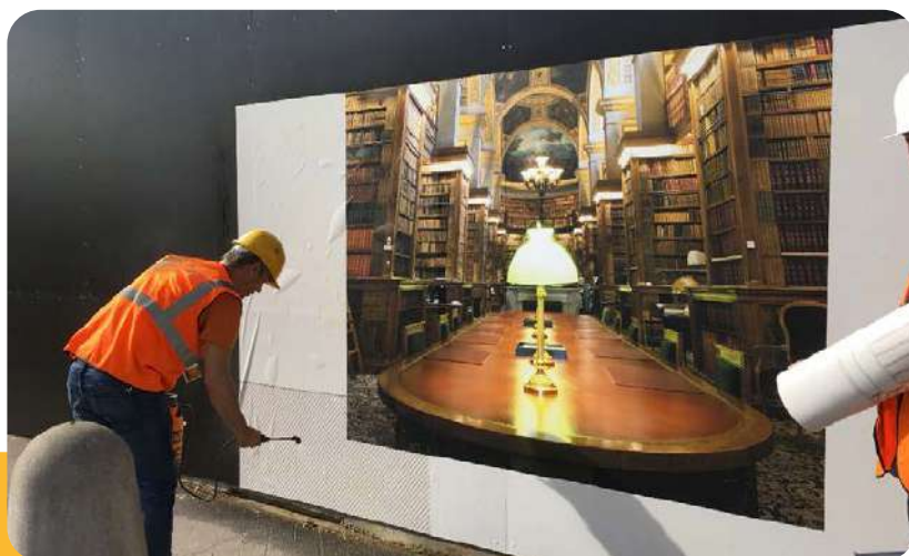
Adhésivage sur une palissade en contreplaqué
