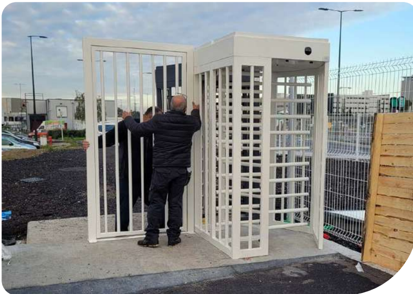
Installation tourniquet de sécurité
