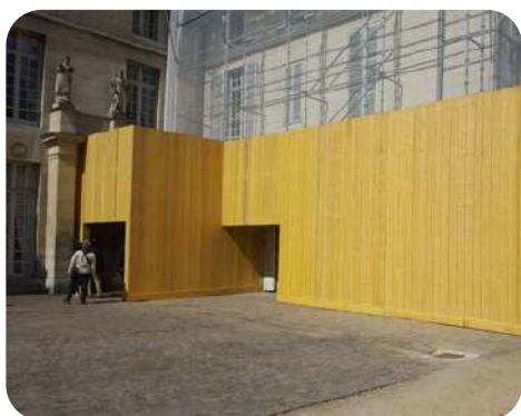
Palissade en « Planche de sapin »
