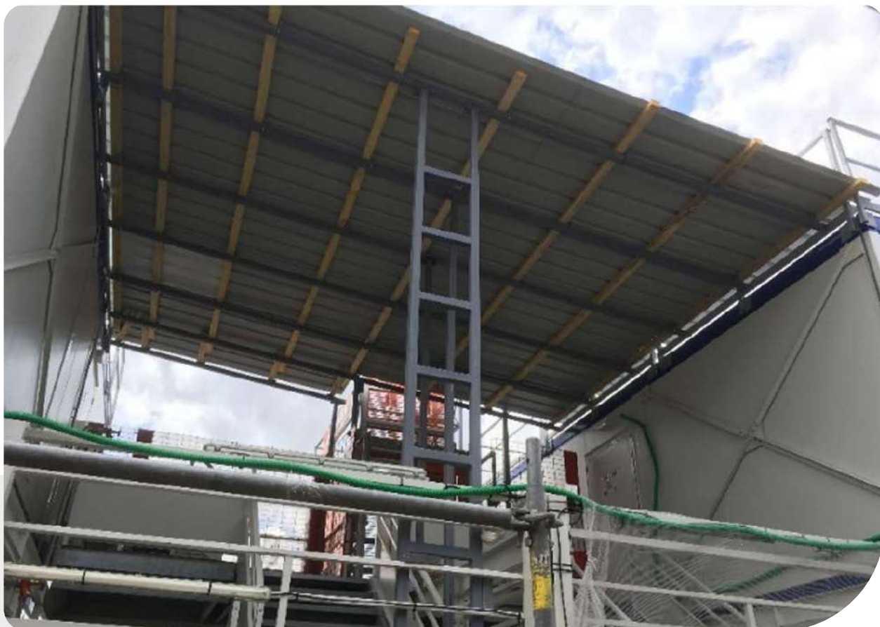
Toit sur structure ferraille bridé sur le dernier étage des bungalows
