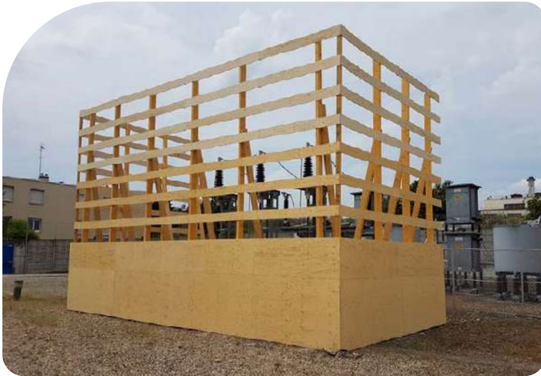
Palissade en Contreplaqué extérieur Utilisation pour bâche
