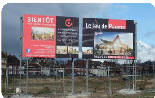
Panneau de chantier sur échafaudage
