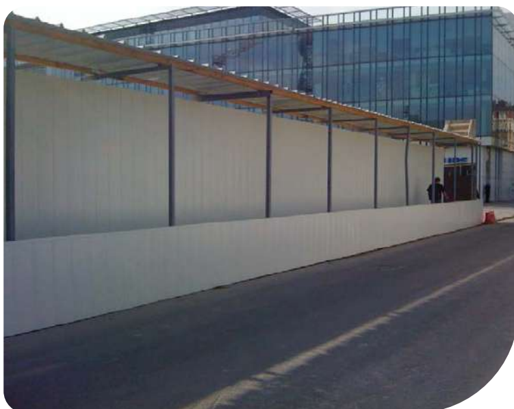
Habillage en tôles nervurées
