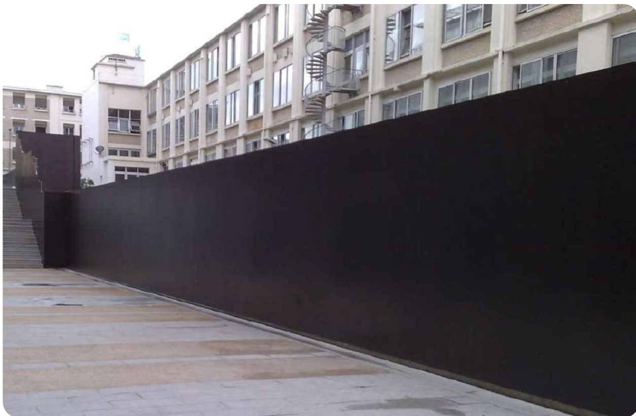
Palissade en Contreplaqué extérieur
