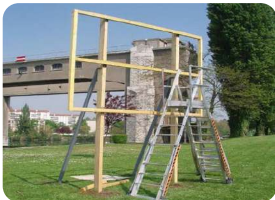
Panneau de chantier en scellement
