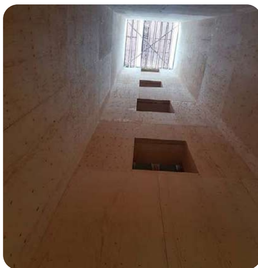
Habillage d'un échafaudage Pour évacuation des gravats
