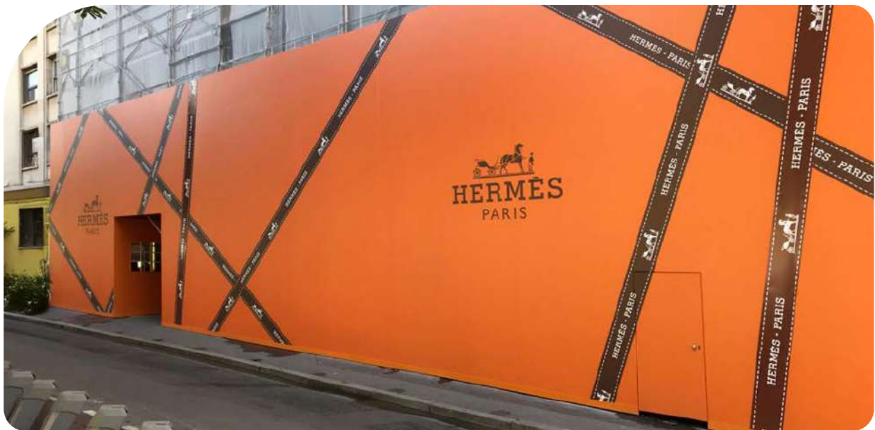
Bâche sur une palissade en contreplaqué
