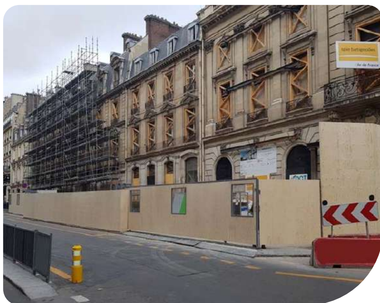
Palissade en Contreplaqué extérieur
