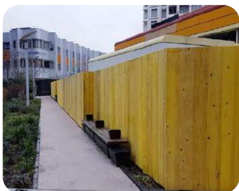
Palissade en « Planche de sapin »
