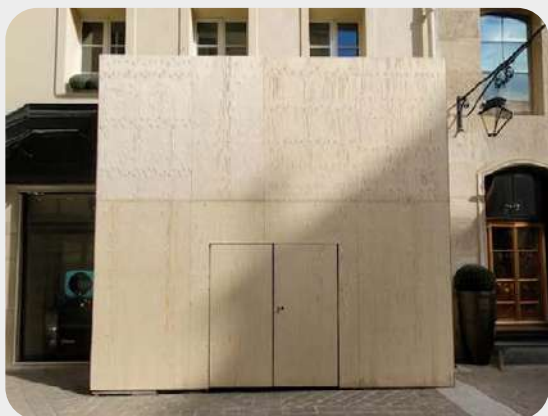
Palissade en contreplaqué extérieur.
