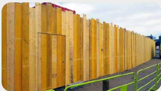
Palissade en « planche de sapin ».
