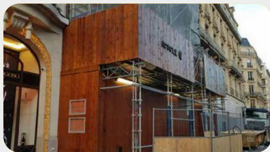
Habillage d'un échafaudage.
