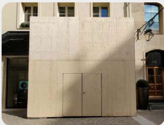
Palissade en contreplaqué extérieur.
