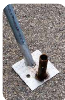
À lester JAMB00003
