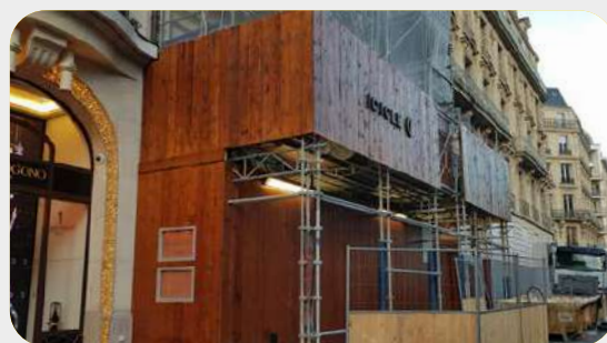
Habillage d'un échafaudage.
