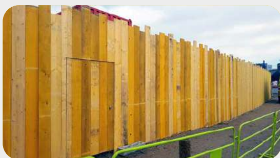
Palissade en « planche de sapin ».
